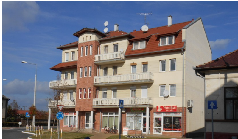
Önkormányzati bérház földszinten üzletekkel, irodákkal
